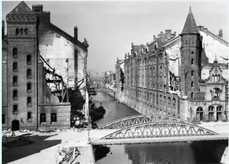
Ruinen der Blöcke L und D in der Speicherstadt Hamburg
