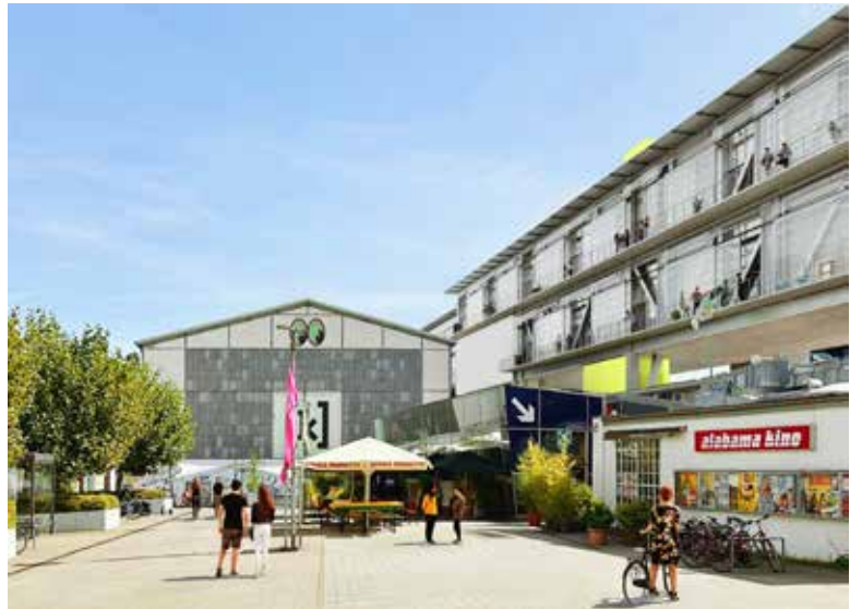
Der geplante Kampnagel-Neubau (rechts im Bild)
